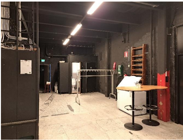
Kuva 33: Pohjois- ja eteläosien välinen seinä.
