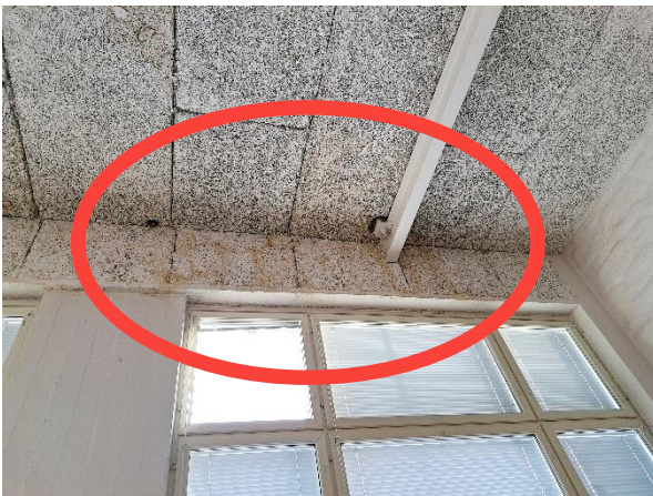
Kuva 29: Vuotojälkiä tilassa 120.
