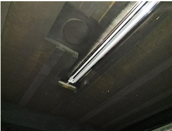
Kuva 43: Pohjoisosan sisäkattopinta on maalattua mineraalivillalevyä.
