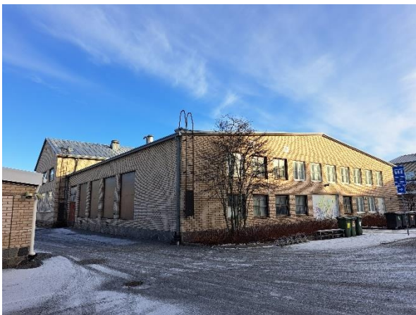
Kuva 25: Ikkunat ovat pääasiassa alkuperäisiä, osa on levytetty umpeen.
