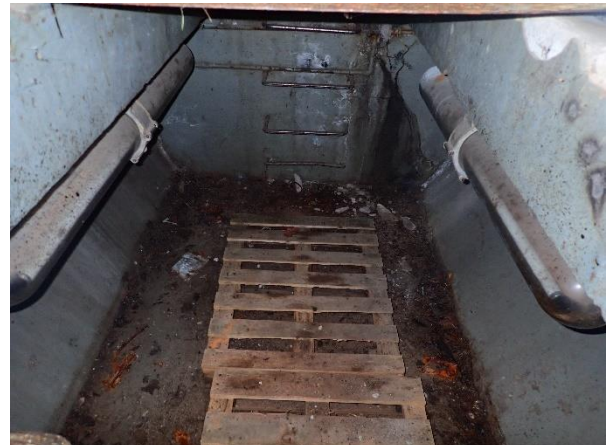
Kuva 11: Tilan 107 pesu- ja öljysyvennys.
