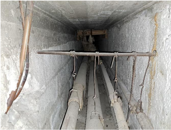
Kuva 49: Länsisivulla sijaitseva putkikanaali.
