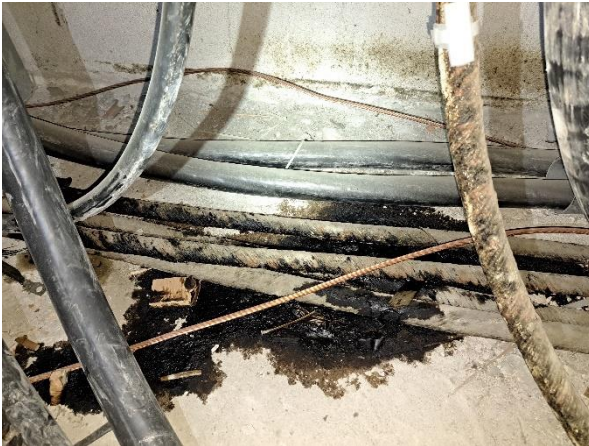
Kuva 6: Itäpuolella olevan sähkötilan alapohjaa.
