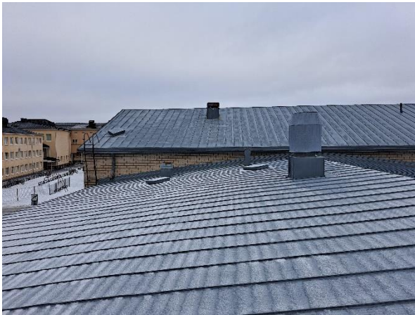
Kuva 37: Vesikatto on tyydyttävässä kunnossa.
