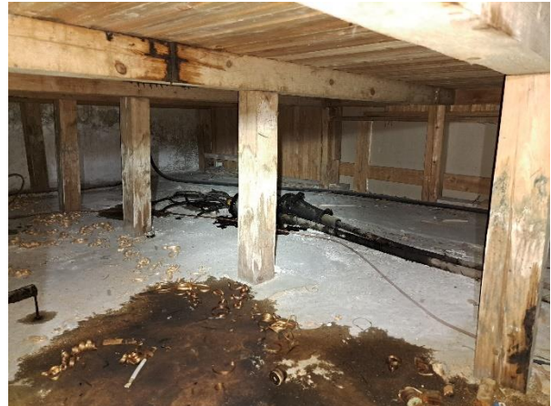
Kuva 7: Itäpuolella olevan sähkötilan alapohjaa.
