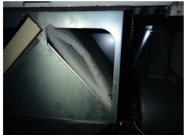
Kuva 46: P-2 IV-koneen suodattimet on vaihdettu.
