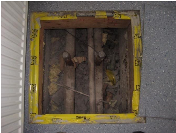
Kuva 17: Itäpuolen putkikanaalin tarkastusluukku.
