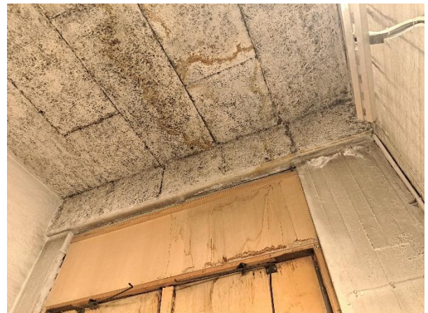
Kuva 30: Vuotojälkiä tilassa 127.
