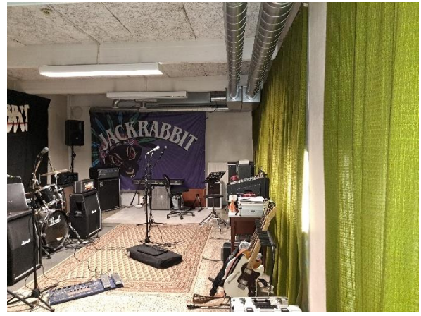
Kuva 20: Sisäkaton sementtilastuvillalevytystä, lattia mosaiikkibetonia.
