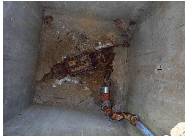
Kuva 14: Kaivossa on valurautainen viemäriputki ja siihen johdettu tippavesiputki entisen autokorjaamon lattiarakenteesta.
