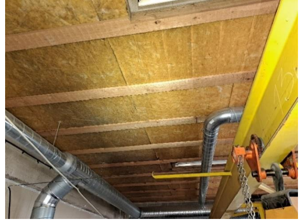
Kuva 42: Pohjoisosalla pinnoittamatonta mineraalivillalevyä.
