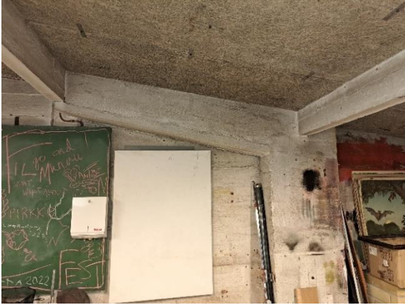
Kuva 41: Eteläosan reuna-alueilla yläpohja mukailee kattomuotoa.
