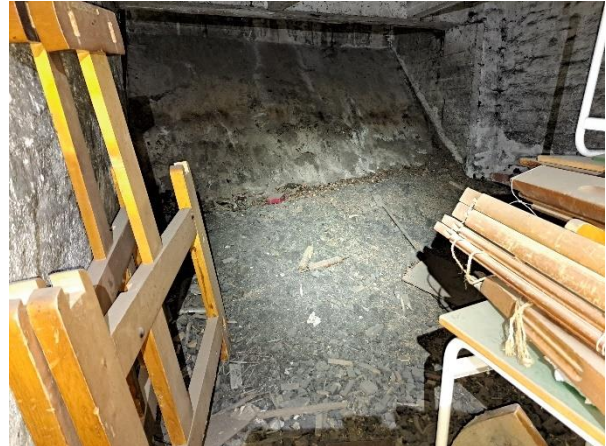
Kuva 5: Länsipuolen kellaritilan entinen hiilivarasto.
