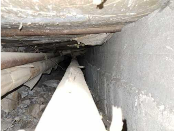
Kuva 47: Itäisivulla sijaitseva putkikanaali.
